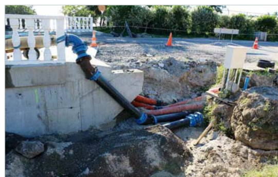
Les différentes canalisations ont été installées de façon provisoire afin pouvoir alimenter en eaux les nombreux foyers de cette zone de Varari/Haapiti
