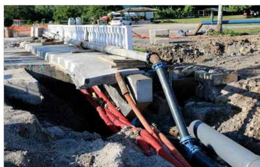
Les différentes canalisations ont été installées de façon provisoire afin pouvoir alimenter en eaux les nombreux foyers de cette zone de Varari/Haapiti
